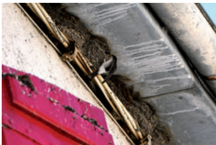
Maison du 48 rue Aliénor, 9 nids ont été rebâtis. Le pose d'une planche sera nécessaire pour assurer la propreté.
