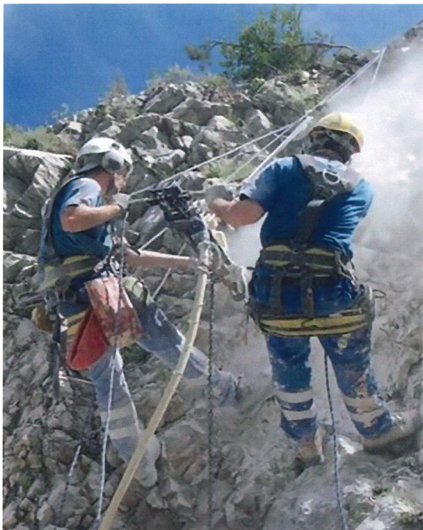
Forage des ancrages
