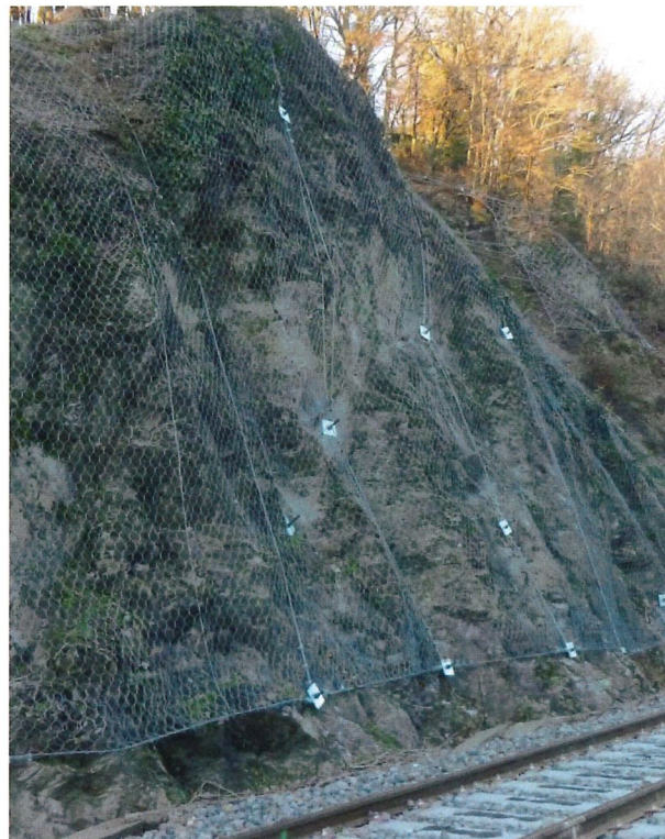
Pose de grillage
