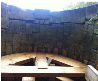
Fissure ouverte entre la maçonnerie de la voûte et les claveaux de l'arc du parement Ouest
