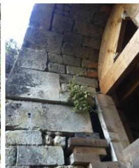
Fracture des maçonneries à proximité des pierres formant piédroit de l'ouverture du passage
