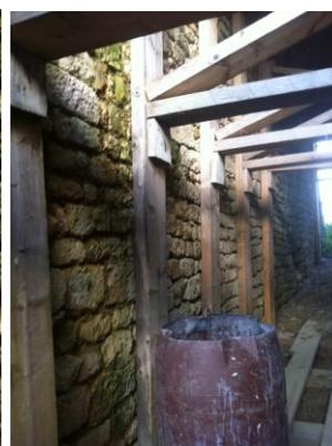
Vue du parement en moellon des élévations du passage. A noter, le déjoints général.
