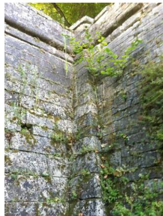
Détail de l'angle Sud de l'élévation Est - A noter, l'altération du parapet de l'orillon.
